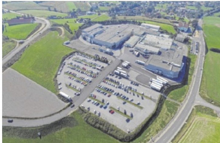
Auf einer Betriebsfläche von rund 32.000 Quadratmetern werden täglich frische Fleisch- und Wurstwaren hergestellt.
