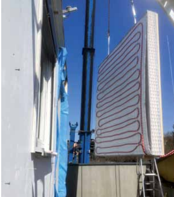
Einbau des Fassadenprototyps aus MultiTab in die Fassadenprüfeinrichtung bei AEE INTEC
