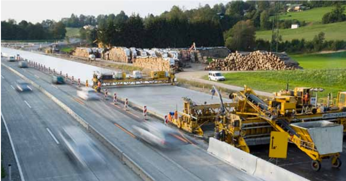
Aktuell baut die ASFINAG sechs Projekte im Umfang von etwa 1,5 Mrd. Euro in Oberösterreich. © waldhaeusl.com
