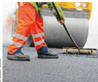
Die Sanierung der Draschestraße läuft auf Hochtouren.
