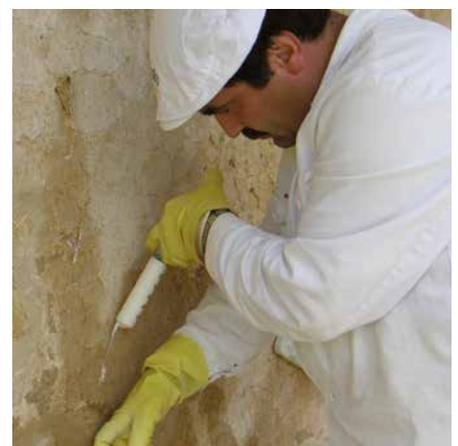
Konsolidierung des barocken Kalkputzes, Hinterfüllen von Hohlstellen mit Kalkmilch bzw. flüssigem Kalkmörtel
