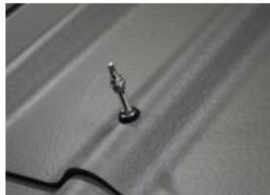
Stockschraube bei Structa Dachplatte
