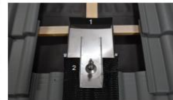
1 Universal-Dichtungskell setzen 2 Schürze festkleben
