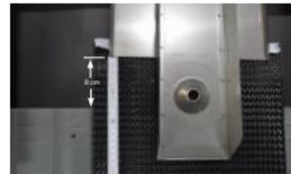
Das Solarblech 8 cm oberhalb des Dachsteins im Bereich des Sparrens setzen
