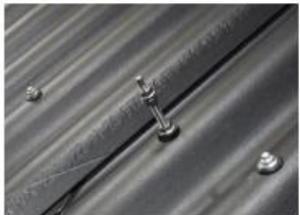
Stockschraube bei Wellplatte P6
