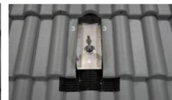
3 Dachsteine links und rechts beidecken 4 Stockschraube setzen (separat erhältlich)
