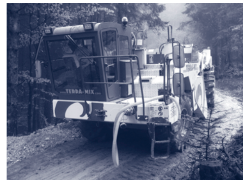
Vermischen von Holzasche mit Schotter im Forstwegebau
