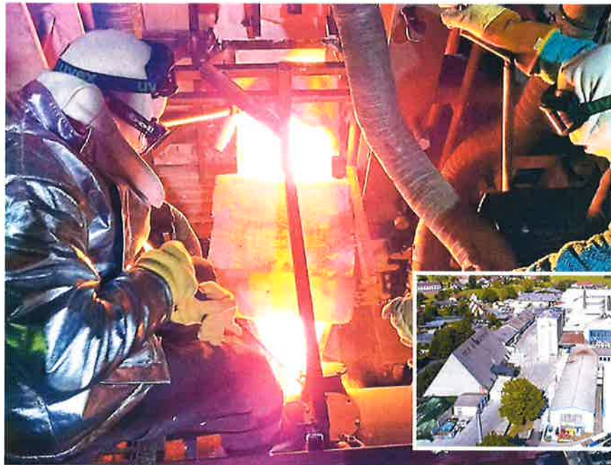
Das Ablassen einer Glaswanne (gr. Bild) am Standort in Köflach wäre ein langwieriger Prozess.
