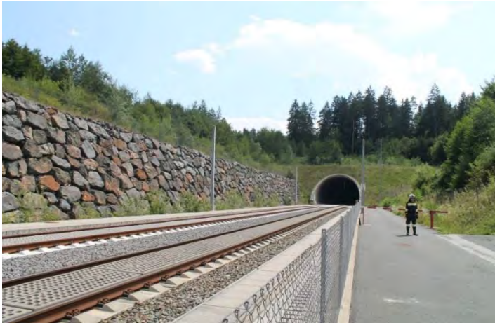
Abb.21 Hengsbergtunnel Nordportal westlich von Wildon während einer Brandschutzübung
