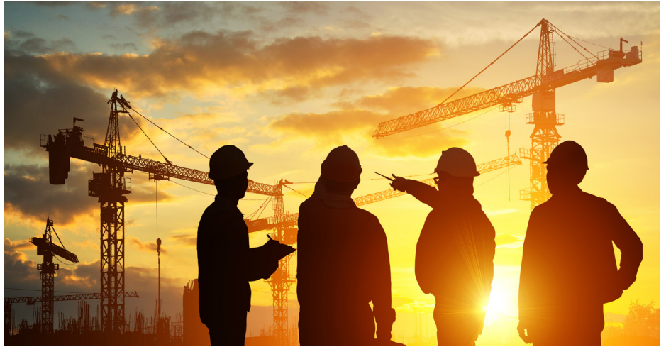
Digitale Bauverfahren und ein bewusster Umgang mit Ressourcen sind ein wichtiger Schritt für die Zukunft am Tiroler Bau.
