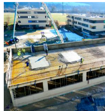
Im Garten entsteht ein neues Therapiegebäude.
