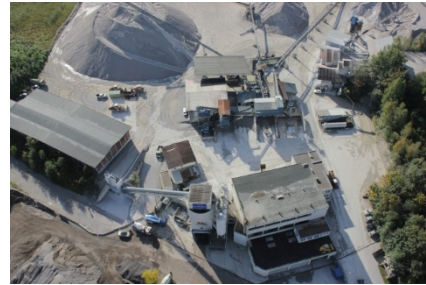
Wimpissinger Transportbeton Kundl
