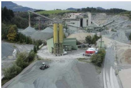
HWK Transportbeton Oberndorf
