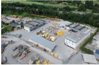
Bodner Zentralbauhof Kufstein
