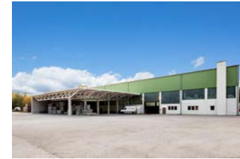
DYWIDAG Bauhof Ennsdorf
