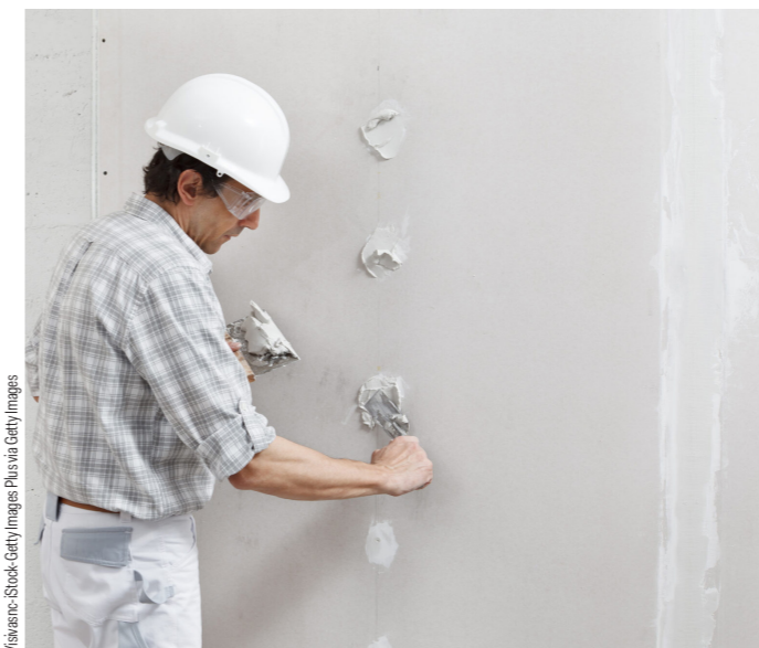
Das bloße Verspachteln von Gipskartonwänden wird von der Rechtsprechung nicht als unterscheidbares Werk qualifiziert und ist daher rechtlich als Arbeitskräfteüberlassung zu werten (VwGH 9.11.2009, 2007/09/0345). Rechtsfolge ist unter anderem, dass der Haftungsbetrag bei der Auftraggeberhaftung (AGH) aktuell 40 % (und nicht 25 %) beträgt.
