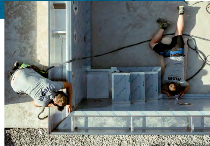
Rund 2 bis 3 Wochen schweißen die Felder-Metalltechniker an einem Edelstahlpool vor Ort.
