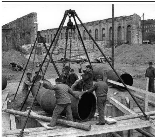
Verlegung eines Hauptstranges der Wasserleitung vor dem zerstörten Westbahnhof, 1950
