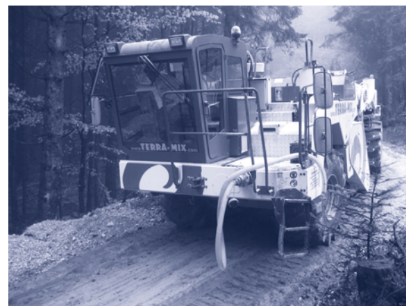
Fräsearbeiten beim Einarbeiten von Holzrasche im Forstwegbau
