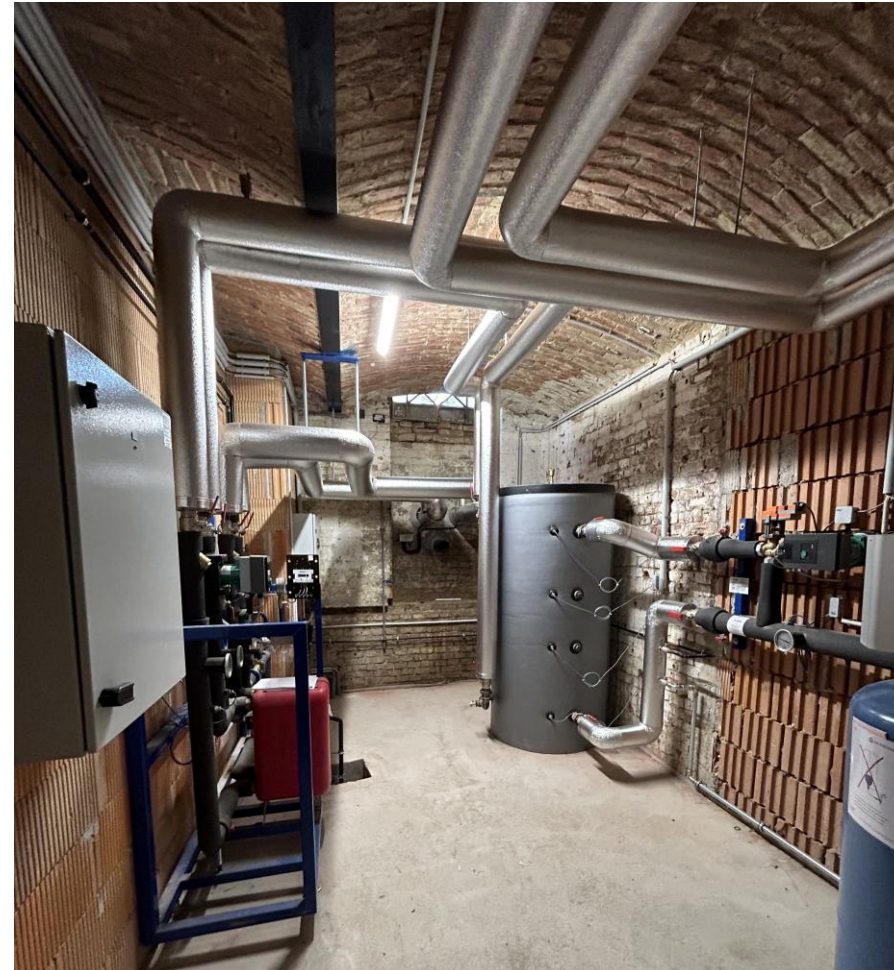
Hausstation 200kW inkl. 1.000 Liter Pufferspeicher von Installationsunternehmen (IFM) errichtet.
