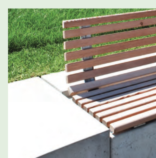
SICHTBETONKANTEN teilweise mit Holzauflege
