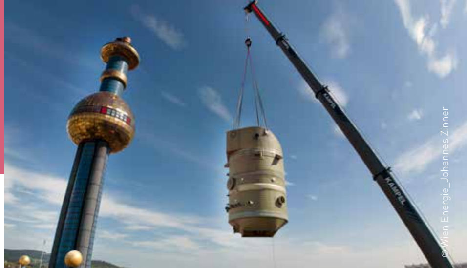
Eine Hochtemperatur-Großwärmepumpe in der Müllverbrennungsanlage Wien Spittelau sorgt in Zukunft für die nachhaltige Fernwärmeversorgung von zusätzlich 16.000 Haushalten.
