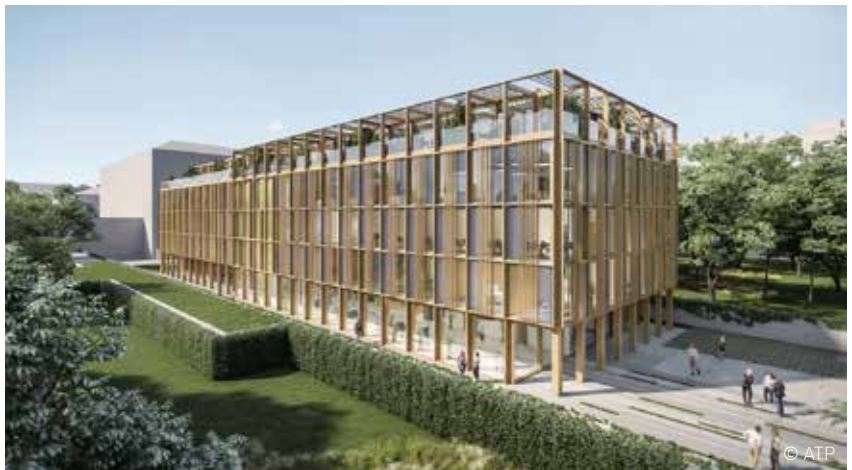
Das Patentamt Wien wird komplett entkernt und rundum neu gestaltet. Die Strobl Bau-Holzbau setzt dabei Holzriegelwände mit eingebauten PV-Paneele, die vor das Stahlbetonskelett vorgesetzt werden, ein.
