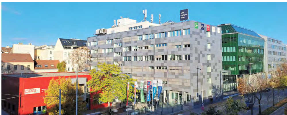
In zwei Jahren Bauzeit hat die WK Wien die Lernumgebung am wko campus wien am Währinger Gürtel 97 (18. Bezirk) neu gestaltet und auf den modernsten Stand der Technik gebracht.
